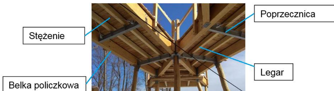
Fig. 3 Widok ogólny elementów konstrukcyjnych pochylni (fot. S. Czernik)
