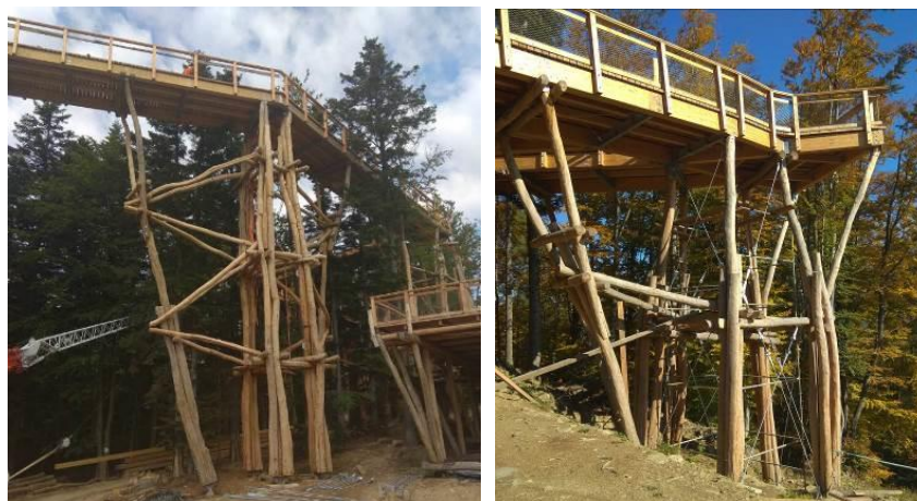
Fig. 4 / Fig. 5 Widok ogólny elementów konstrukcyjnych podpór ścieżki (fot. S. Czernik)
