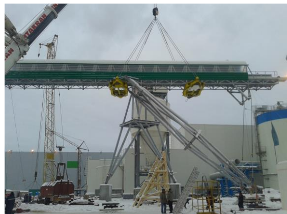
Rys. 9. Jak wyżej - widoczne łańcuchy odciągowe z możliwością regulacji kąta pochylenia podpory ukośnej
