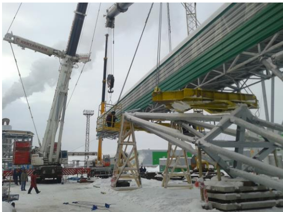
Rys. 8. Czynności przygotowawcze przy podnoszeniu pierwszego segmentu mostu - podnoszony ciężar to ok. 56 ton
