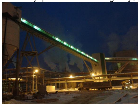
Rys. 22. Widok konstrukcji wsporczej z częściowo zamontowanym oświetleniem
