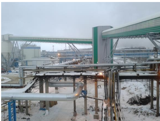
Rys. 21. Widok zmontowanej konstrukcji wsporczej
