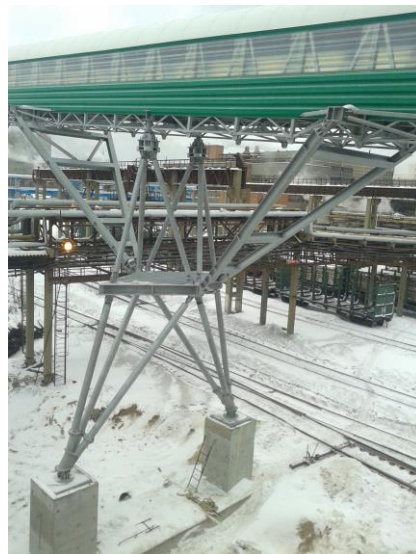
Rys.18. Homoidalna podpora wahaczowa z widocznymi regulowanymi hydraulicznie węzłami
