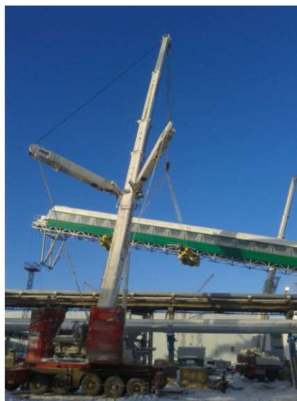
Rys. 11. Podnoszenie pierwszego segmentu drugiej linii - widoczny kontrolowany przechył wstępny
