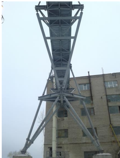
Rys.17. Homoidalna podpora wahaczowa - widok z przodu
