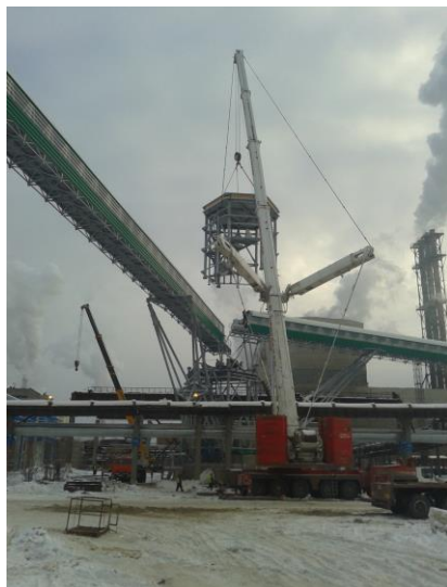
Rys.19. Etap scalania dwóch segmentów wież
