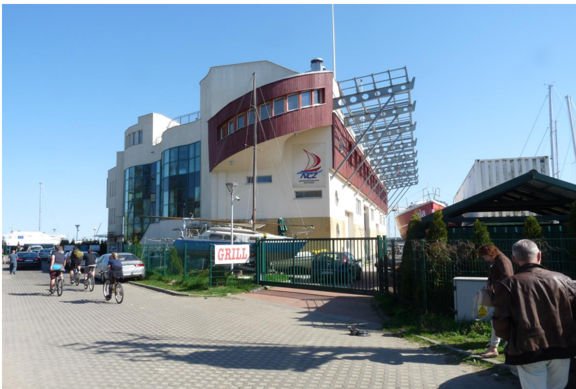
Fig. 2. Gdańsk Górkki Zachodnie NCŻ – Elewacja północna o falującej powierzchni i zachodnia z nadwieszeniem wejść „od deszczu”
