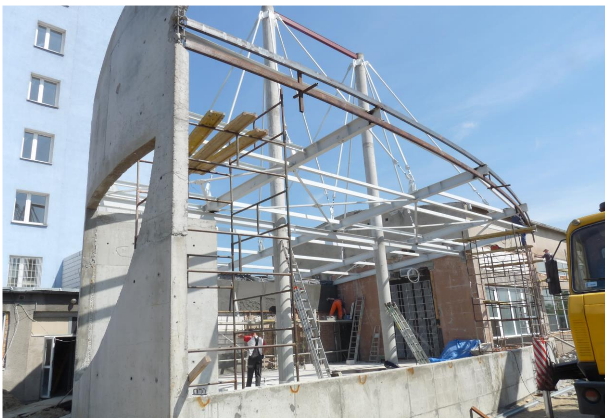
Fig. 5. Gdańsk ul. Marynarki Polskiej 96 . Powstająca innowacyjna struktura systemu konstrukcji minimalizuje ilość robót fundamentowych przez oparcie przekrycia dachu na belkach stalowych wiszących na cięgnach utwierdzonych w dwóch żelbetowych słupach z belką-ściągą.(arch. Grzegorz Rzepecki, konstrukcja ElżbietaWewiórska, z zespołem)
