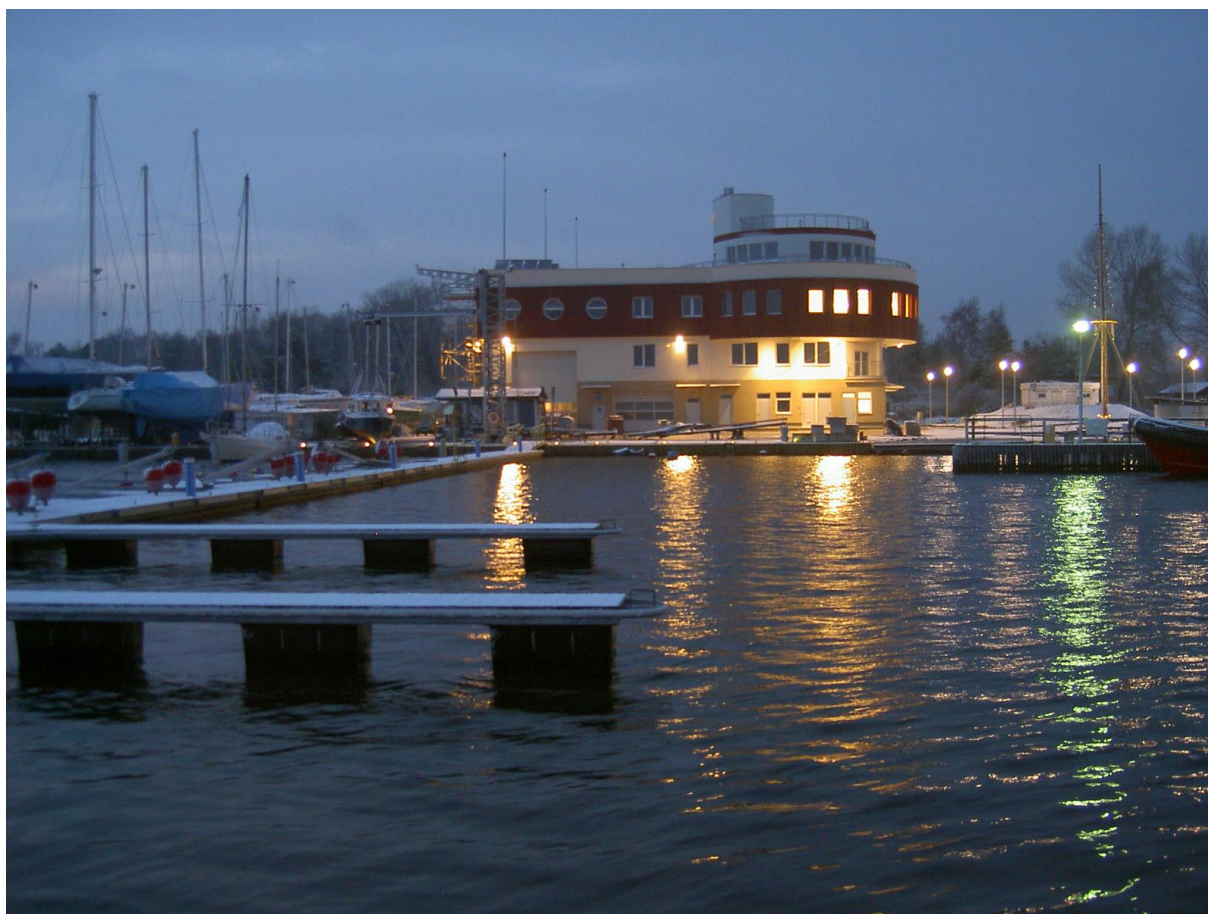
Fig. 4 . Widok z pomostu na zrealizowany iluminowany nocą obiekt z masztami bez lin pierwotnie mających pełnić cięgna wiszącej konstrukcji
