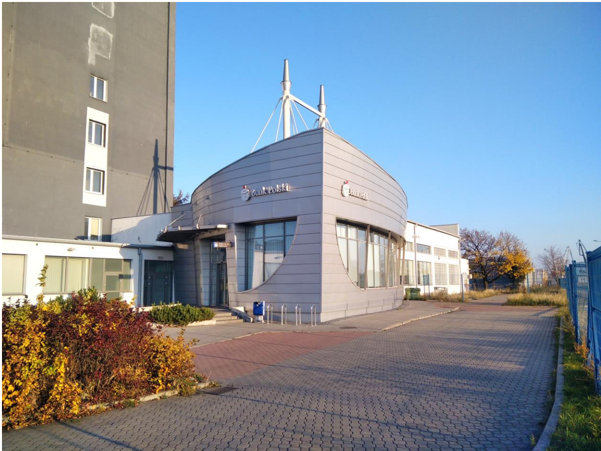
Fig. 6 Widok po zakończeniu prac budowlanych bryły budynku Oddz. Nr 2 PKO BP w Gdańsku stanowiącego dobudowę z przebudową części dawnego laboratorium firmy Budimor SA, którego w głębi dawna forma po wcześniejszej estetyzacji zachowała generalnie pierwotny kształt ( arch. G. Rzepecki z zespołem)
